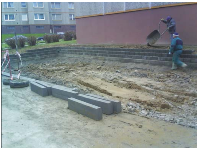
Rozšíření parkovací plochy na sídlišti Střelecký vrch.
